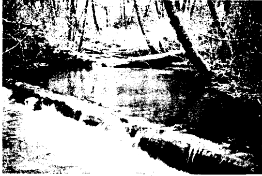
写真-2 樹木の導入による魚類生息場の造成の一事例 (写真流路内の流木はすべて人工的に導入され、ケーブルで溪床に固定されている)
