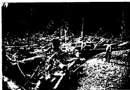
写真6 溪流内の流木滞留
